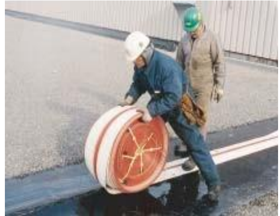
RedLINE 20 instalado en cubiertas
