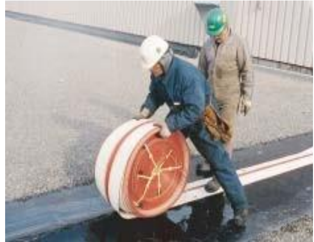
RedLINE 100 Instalado en cubiertas de Terrazas
